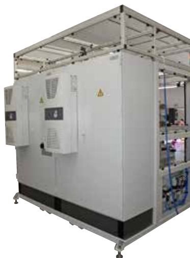
Klimatisierte Einhausung für Schaltschrank und Pumpenstation
