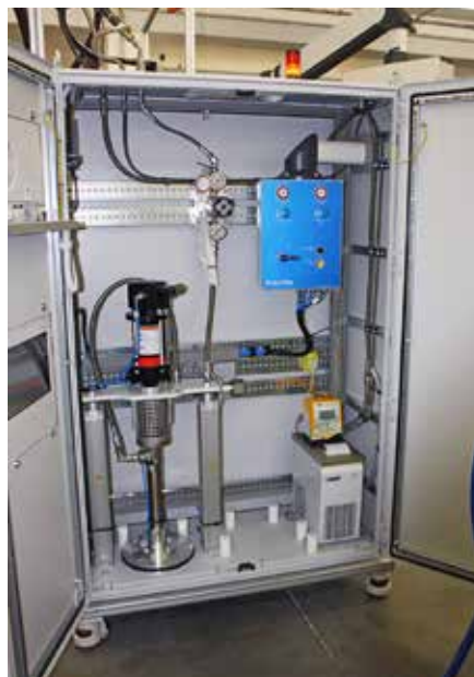
Klimaschrank mit Einfachpumpenstation
